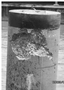
Hình 3a,b – Cọc bị vỡ đầu sau khi đóng
