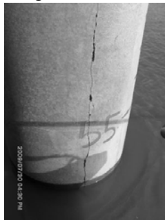
Hình 2 a,b – Vết nứt dọc (nhìn bên ngoài và bên trong lòng cọc)
