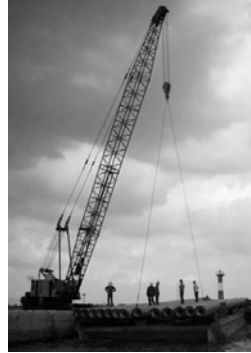
Hình 1a,b – Cầu chuyên cọc ống bằng cách móc vào 2 đầu
