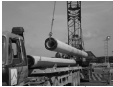
Hình 1a,b – Cầu chuyên cọc ống bằng cách móc vào 2 đầu
