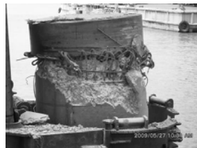
Hình 3a,b – Cọc bị vỡ đầu sau khi đóng
