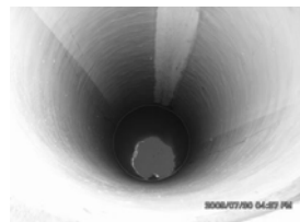
Hình 2 a,b – Vết nứt dọc (nhìn bên ngoài và bên trong lòng cọc)
